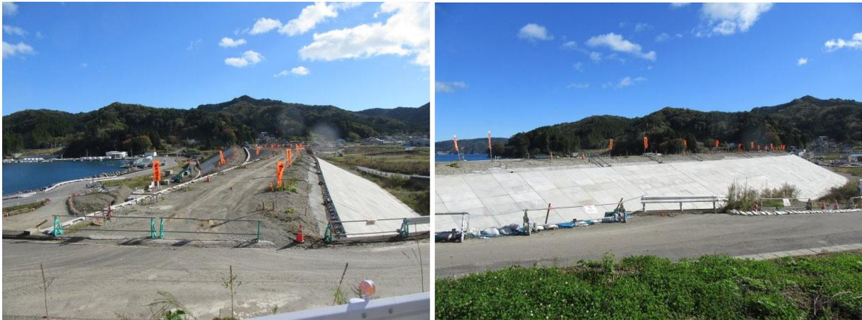
Bau der 14,5 m hohe Tsunami-Schutzmauer in Hakosaki-chô (November 2018)
