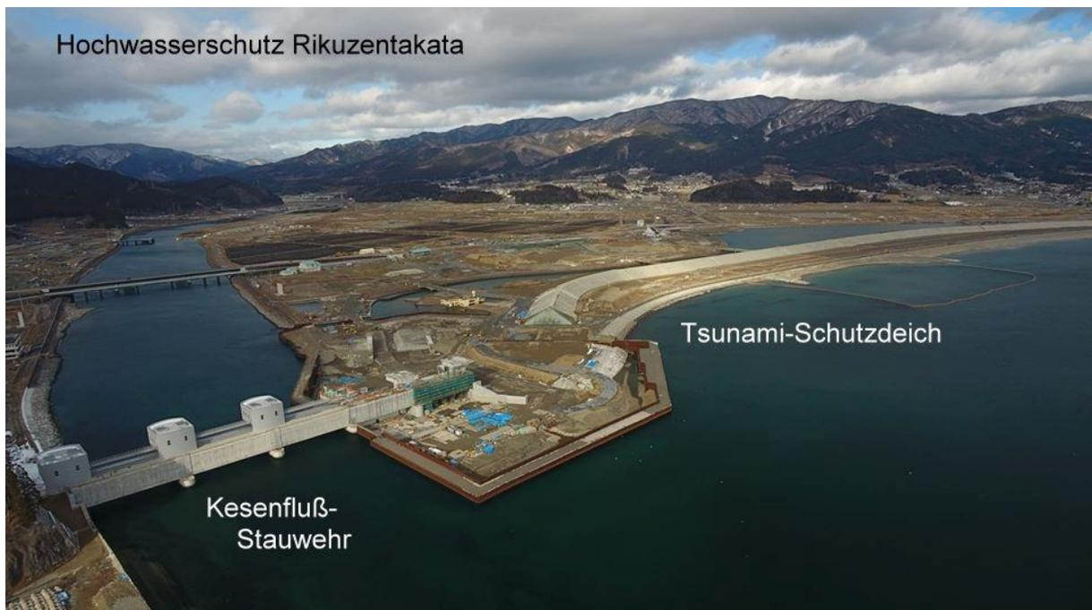
Der Deich verläuft 100 m landeinwärts von der stark ausgebauten Uferbefestigung und weist beidseitig einen Neigungswinkel von  $45^\circ$  auf.
