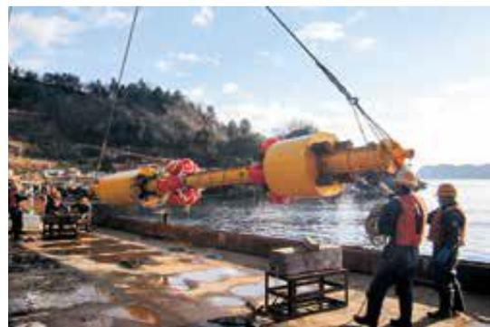
Einmünden sollen die vom "Zentrum für industrielle Entwicklung Kamaishi-Ôtsuchi" gemeinsam mit der Universität Tokyo und der New Energy and Industrial Technology Development Organization (NEDO) durchgeführten Langzeitversuche mit diesem Linearwellengenerator in die Entwicklung eines "Seekraftwerkes Kamaishi".
