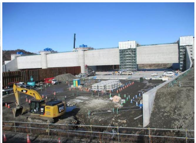
Im Hafengebiet von Ōtsuchi-Ando wird vor dem Schutzdamm ein 20 m hoher Evakuierungsturm gebaut, von dem aus eine Brücke über den Deich auf die Landseite führt. Im Bild unten rechts ist der Bau eines Pfeilers hierfür zu sehen (Stand November 2018).
