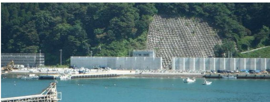
Da nur sehr wenig Platz für die Schutzbauten zur Verfügung steht, werden die vorgefertigten 10,4 m hohen Mauersegmente direkt auf zuvor 15 m tief in den Boden eingesetzte Pfähle gegründet.
