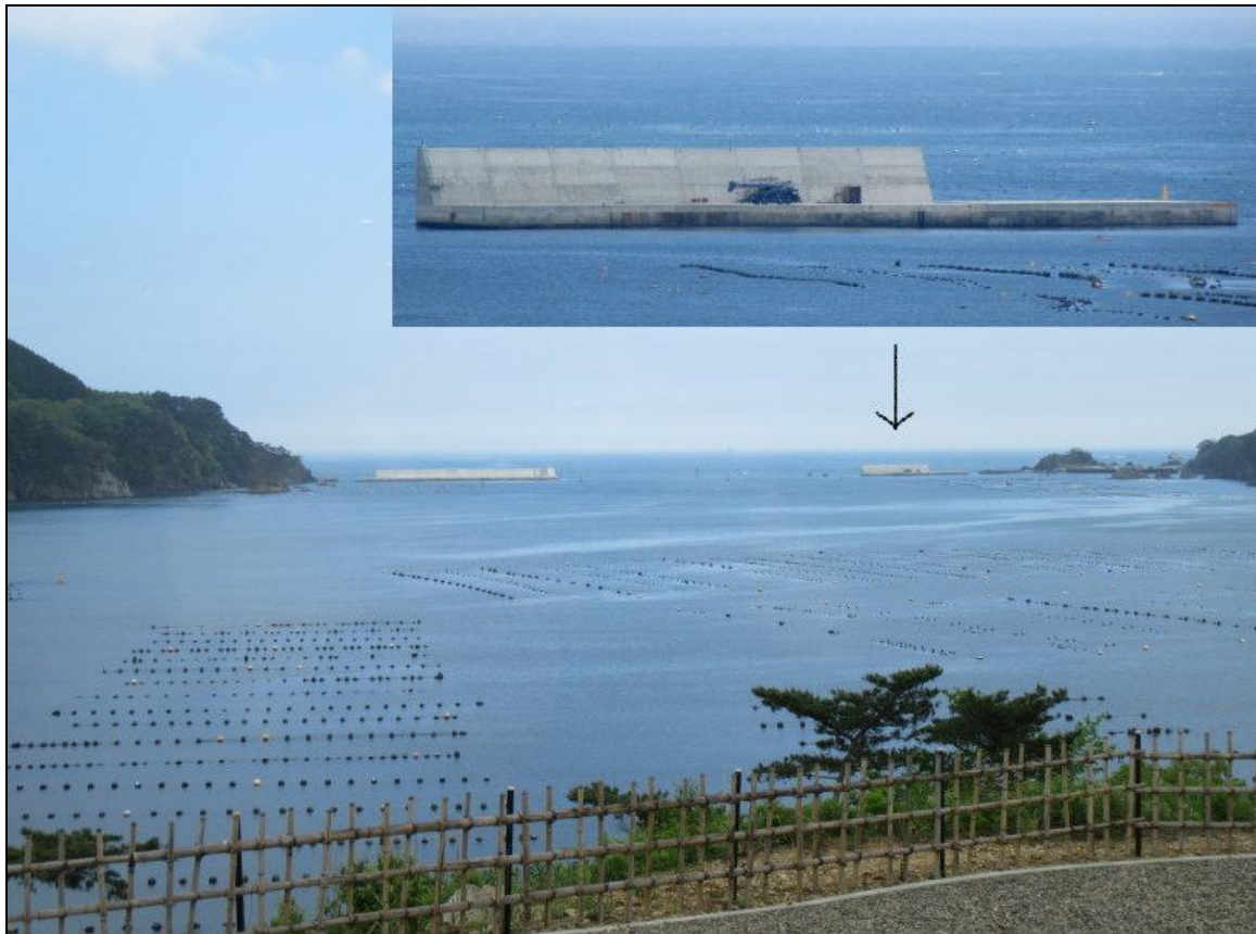
Wiederaufbau der Hochwasserschutzbarriere im Eingang der Ôfunato-Bucht (Stand Mai 2016)
