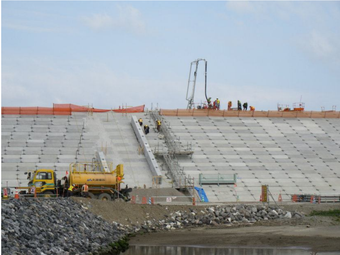
Bau des Tsumani-Schutzdammes in Rikuzentakata (Mai 2016)
