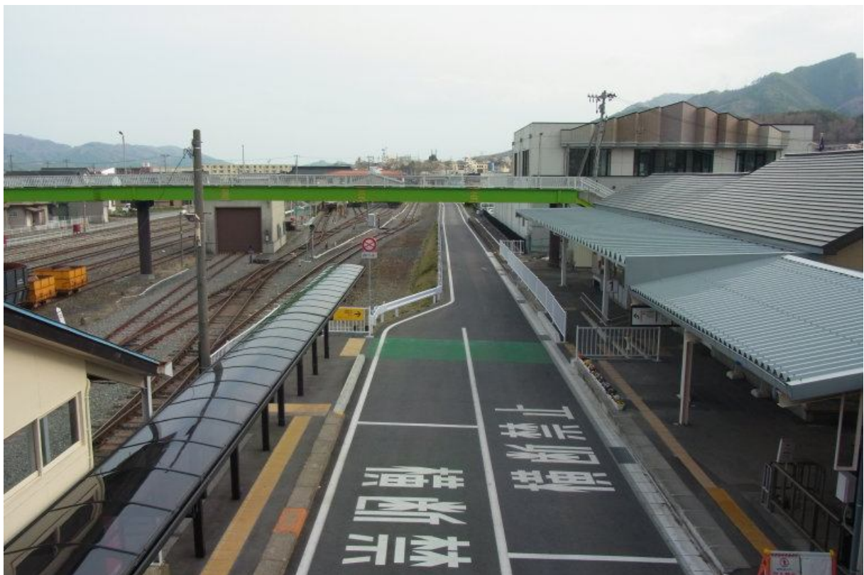
大船渡の盛駅（左: 三陸鉄道南リアス線、右: BRT の終端停留所写真）
