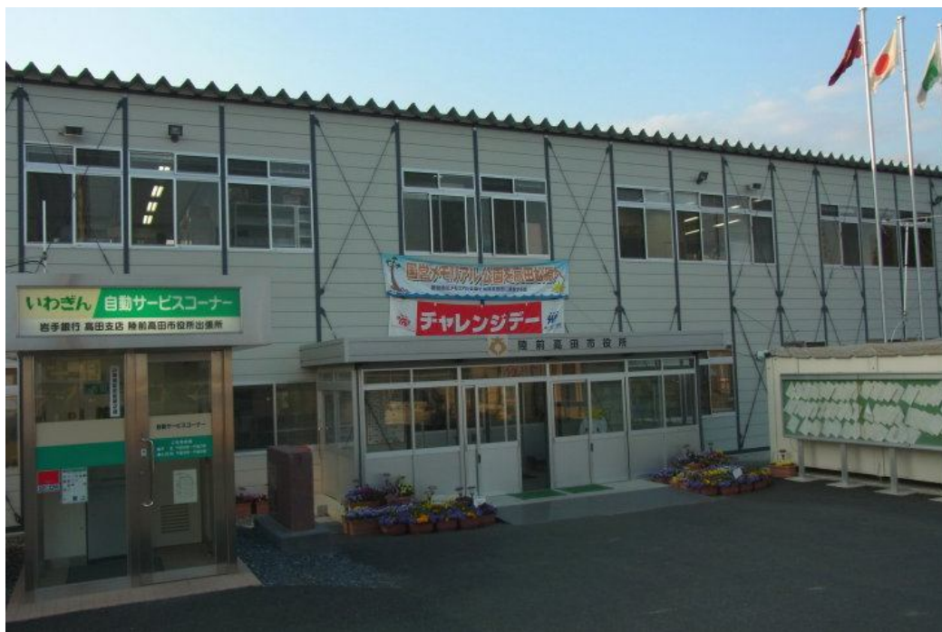
Provisorisches Rathaus von Rikuzentakata
