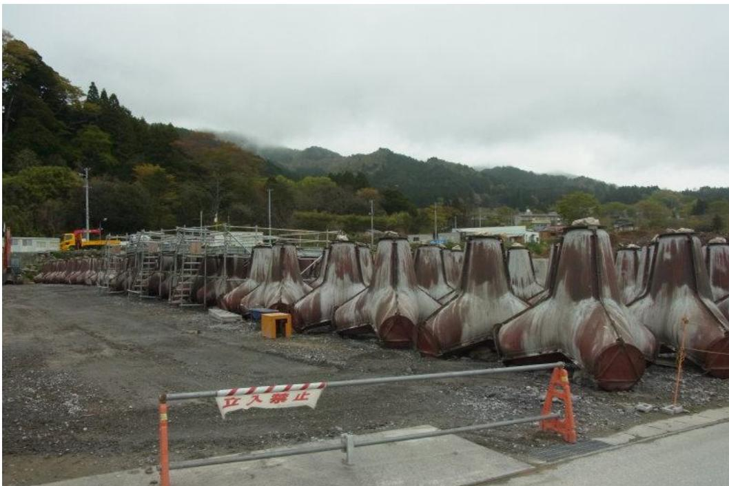
Für die Uferbefestigung werden außerdem vor Ort große Mengen Tetrapoden gegossen.
