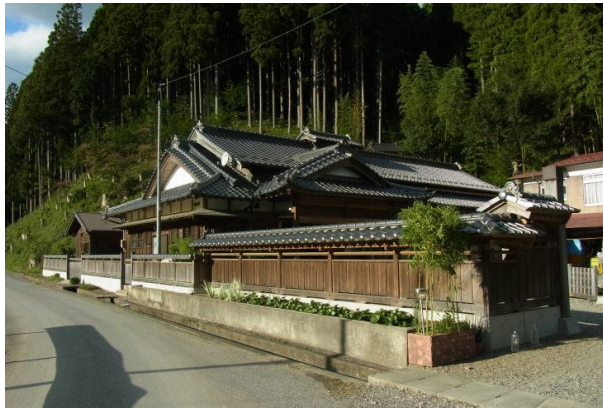
伝統的な民家 (被害を免れた上部の上長部)
